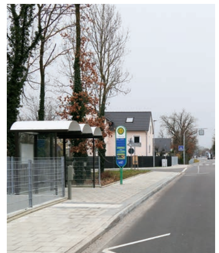
Der fertiggestellte Teil der Südlichen Ingolstädter Straße mit neuem Bushäuschen.
